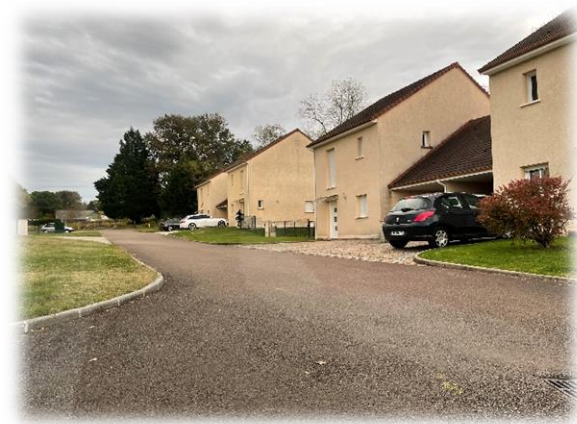
Une opération d'habitat groupé sur le secteur des Combes
