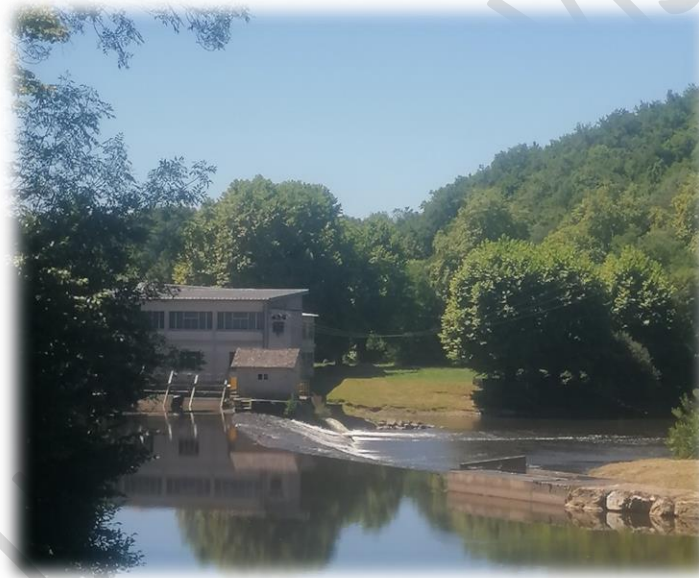
Seuil en rivière (microcentrale hydroélectrique)
