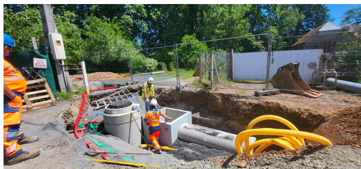
Travaux très attendus au hameau Les Theyres : réfection des réseaux d'eaux pluviales à la charge de la commune et d'assainissement à la charge de l'Agglo de Brive.
