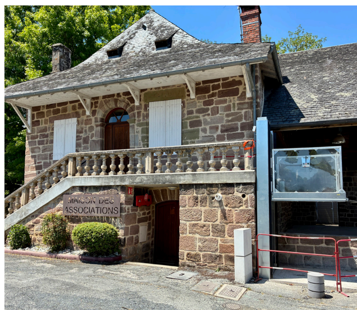
Mise en accessibilité de la Maison des Associations avec l'installation d'un monte-personnes, afin de faciliter l'accès au bâtiment pour les personnes à mobilité réduite.
